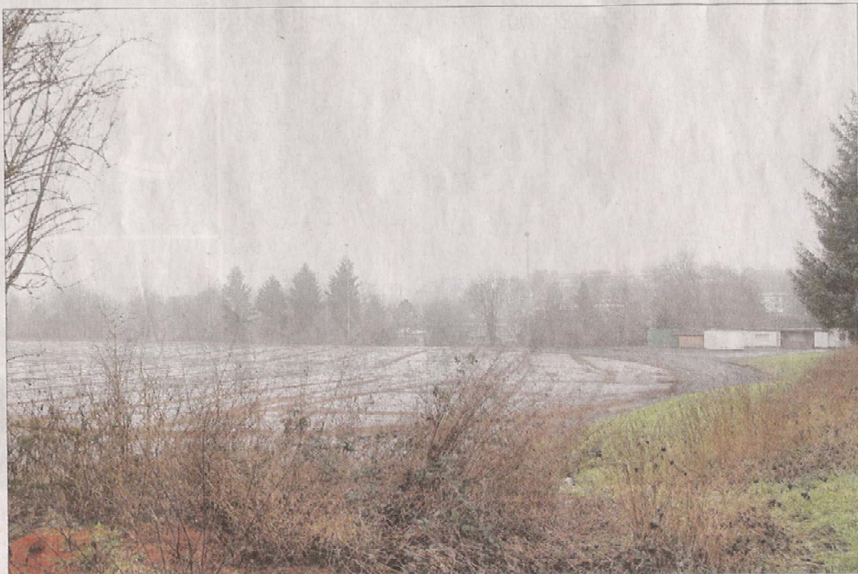
Der Sportplatz in Lindlar – derzeit ruhen wegen des Wetters die Bauarbeiten. (Foto: Schmitz)
